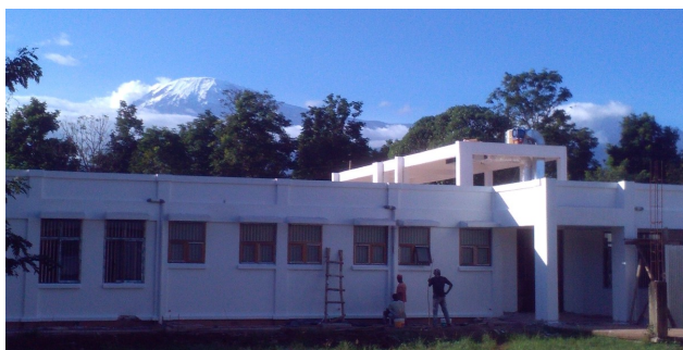
Kilimanjaro torent uit boven de in aanbouw zijnde cardiologieafdeling. Ondersteund door Ziekenhuisgroep Twente onder leiding van Dr Salah Said
