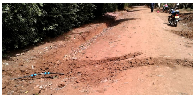
Het Hazenpad naast ons huis, na de wegwerkzaamheden
