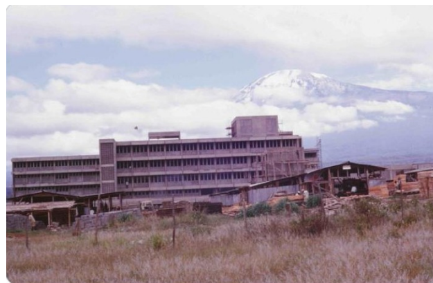
KCMC ziekenhuis in aanbouw in 1969
